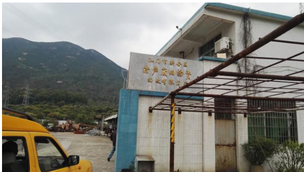
站址东侧-废品回收站
