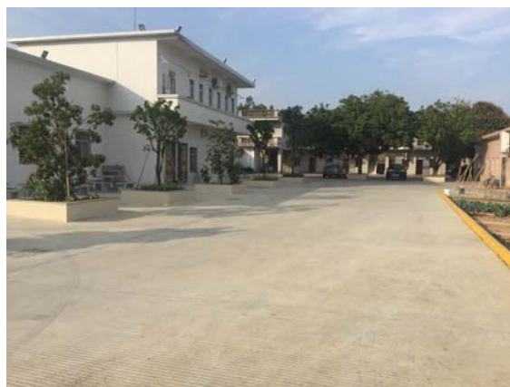
供电所宿舍楼
