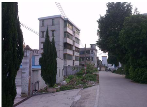
西侧 5 层居民楼
