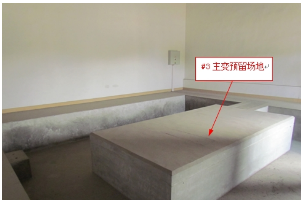
图 4 110kV 永康站#3 主变扩建位置
