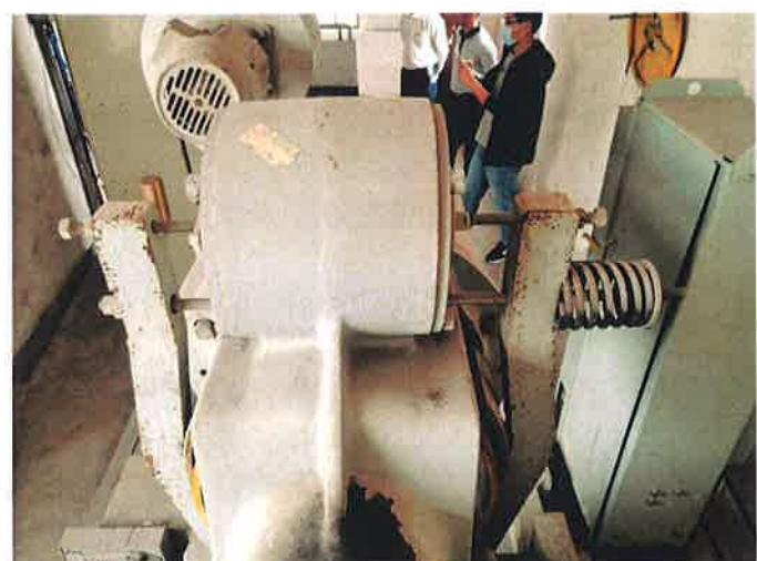
擦碰、电梯轿厢冲顶或蹲底等严重安全事故，严重拖闸还会烧毁曳引电动机；当制动器释放失效时，由于没有设置制动器故障监测，曳引机启动，电梯就会因制动力不足或丧失制动力而不能使电梯制停，造成电梯轿厢溜车，可能引起剪切、擦碰、电梯轿厢冲顶或蹲底的严重安全事故。因此曳引驱动电梯应设置制动器故障保护功能。
