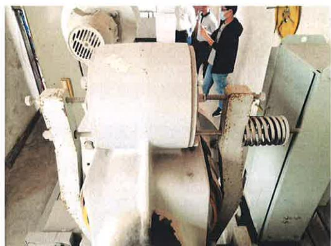
**降低风险措施建议** : 更换制动器装置 , 以降低制动器失效的风险。在此之前 , 电梯使用、维保单位加强电梯日常检查和维护保养 , 严格按照要求更换合格配件 , 并对驱动主机、控制系统、制动系统等适当加密维保次数 , 发现问题立即整改 , 确保电梯安全运行。
