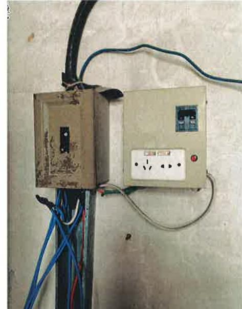
**降低风险措施建议：**更换带锁的电气箱或者加装其他防止误操作装置，以降低误操作引起的触电风险。在此之前，电梯使用、维保单位如有主开关断电维修的，应指派专人看护，并挂禁止合闸标识牌。
