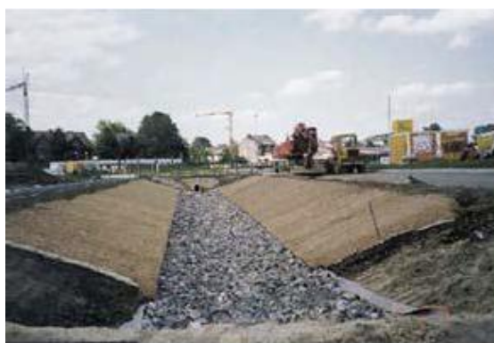
图 6-59 植物纤维毯护坡施工完成初期
