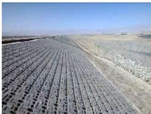
图 6-54 生态连锁块护坡建成初期
