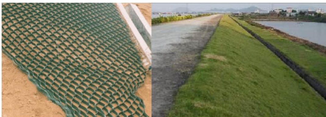
图 6-44 三维土工网施工现场
