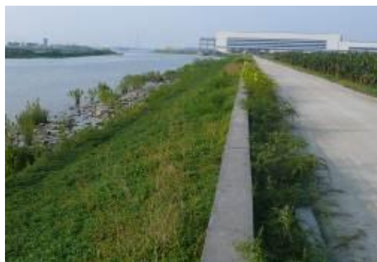
图 6-57 绿化混凝土护坡建成一年后（缓坡）
