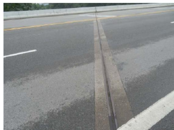
图4-17 2#伸缩缝砂石堵
