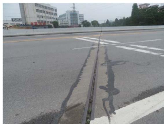
图4-14 2#伸缩缝砂石堵塞
