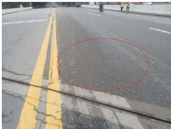
图4-12 1#桥面铺装粗骨料外露
