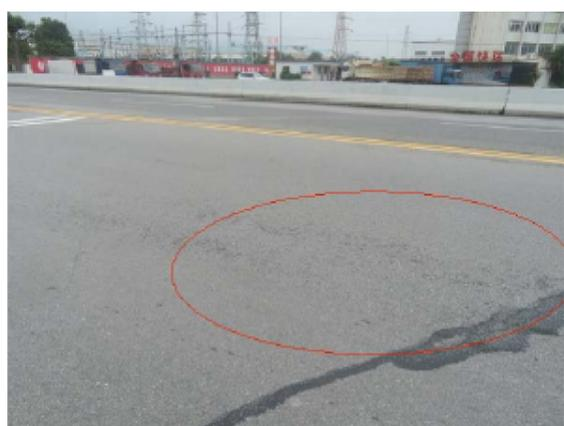
图4-3 2#桥面铺装粗骨料外露
