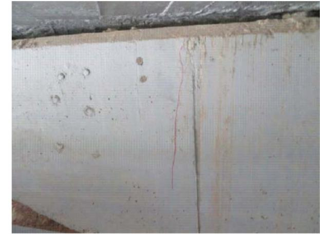
混凝土缺陷修补示意
