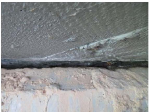
图 4-47 5-5-1#支座被掩埋，无法检测
