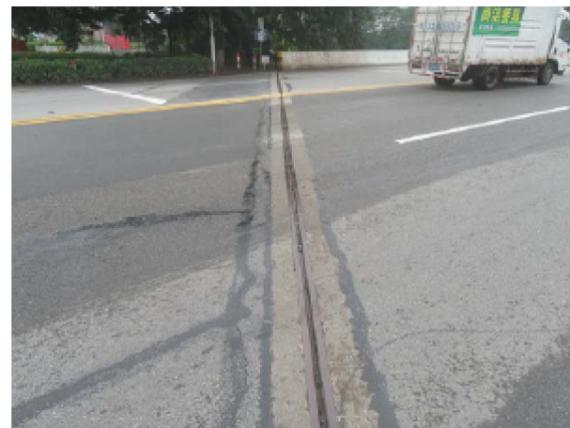
图4-15 1#伸缩缝砂石堵
