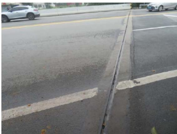
图4-13 1#伸缩缝砂石堵
