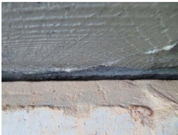
图 4-48 5-5-2#支座被掩埋，无法检测
