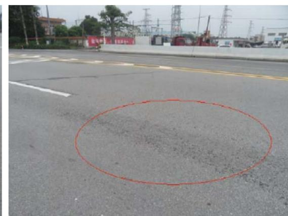
图4-6 3#桥面铺装粗骨料外露
