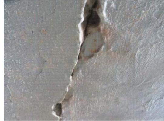
空心板加固钢板锈蚀
