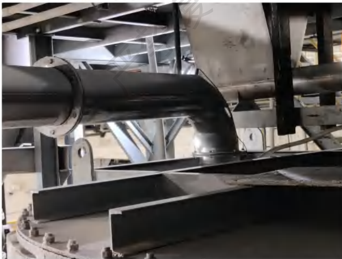
图 4.6-4 干燥废气收集方式示意图
