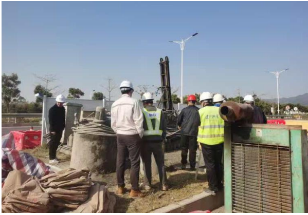
开平市住房和城乡建设局检查“开平市城镇污水处理及管网工程——东环路、G325 管道工程”项目
