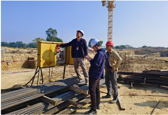
恩平市住房和城乡建设局检查“江门市新瑞峰房地产开发有限公司君临江畔A1栋、A2栋、B1栋、C1栋”项目
