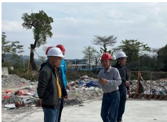
开平市住房和城乡建设局检查“赤坎消防站（开平市西部消防站）建设”项目
