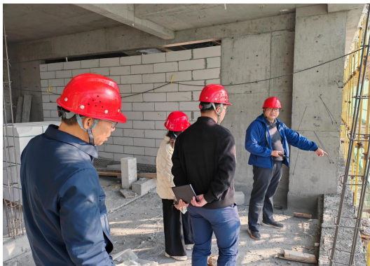
江海区住房和城乡建设局检查 “礼乐中学宿舍楼”项目
