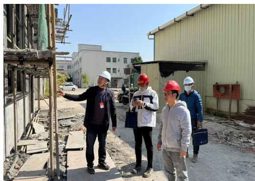
恩平市住房和城乡建设局检查“恩平市金格电子有限公司--厂房一、门卫”项目
