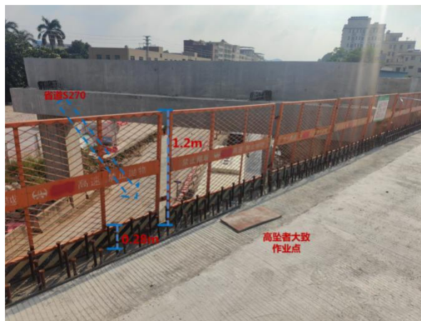
图 1-2 事故现场安全防护栏现场加装后照片 (注：防护栏为事故发生后 9 月 26 日下午安装)
