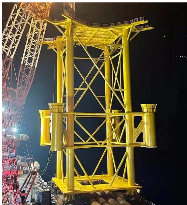
图 2.3.1-3 工艺定位架示意图
