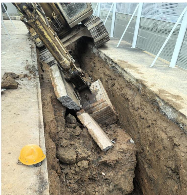
图 6: 混凝土板块及土体向沟槽内坍塌
