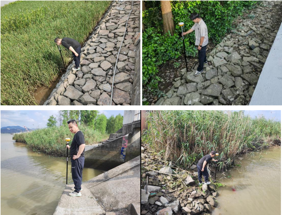
图 7.5.2-1 现场测量照片
