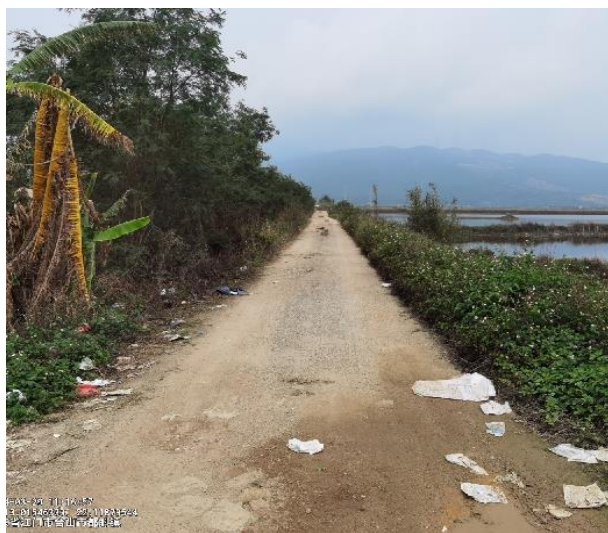
图 2.1.3-8 新六围堤段现状（桩号右 84+366~右 85+279）
