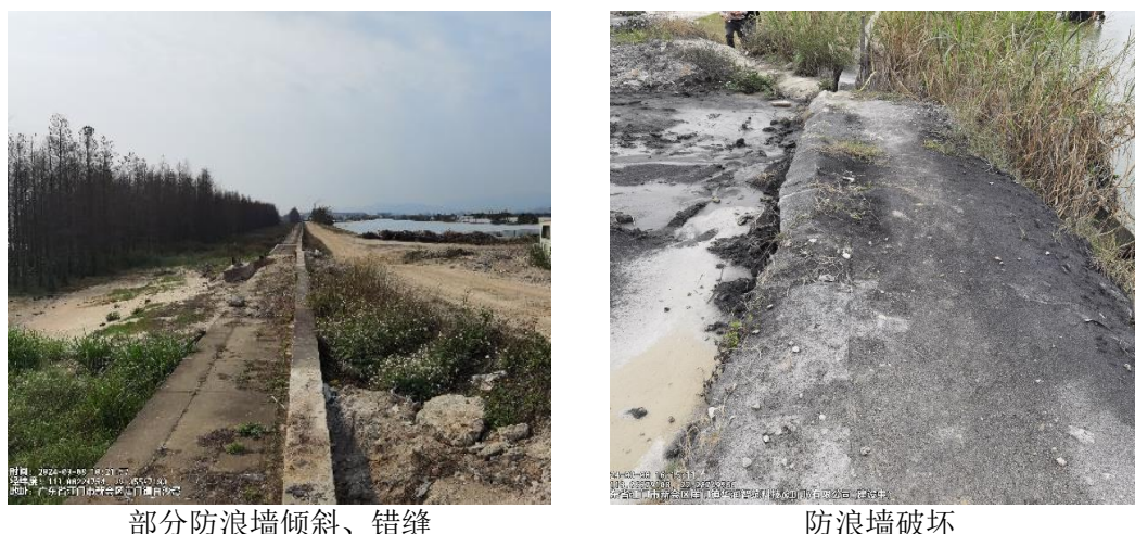
图 2.1.3-5 崖门堤段现状
