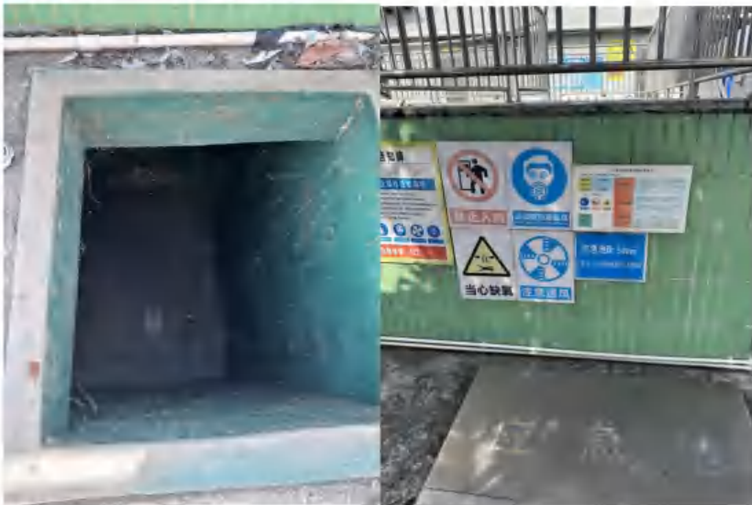
现有事故应急池图片
