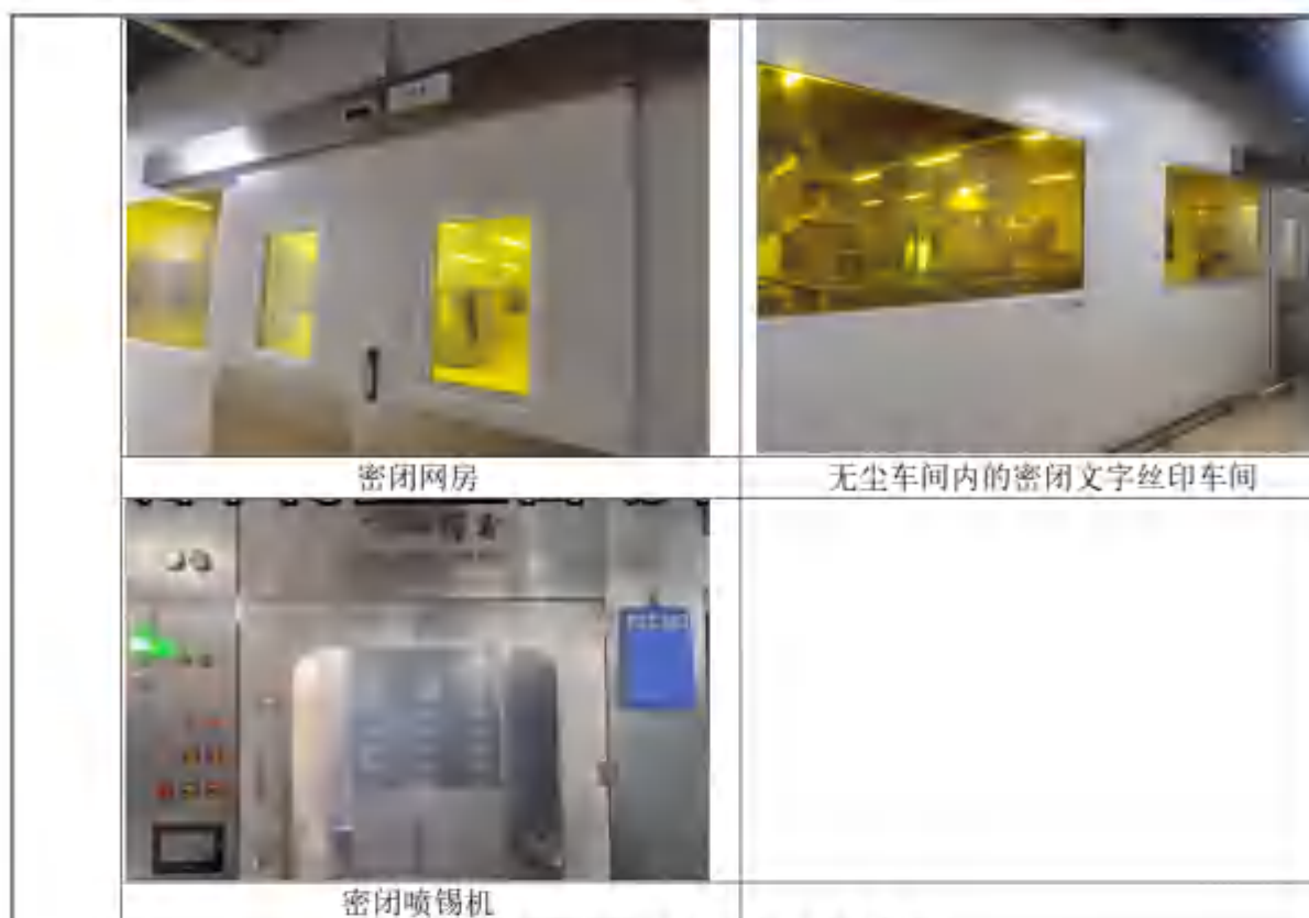
图 1.4-1 有机废气收集措施
