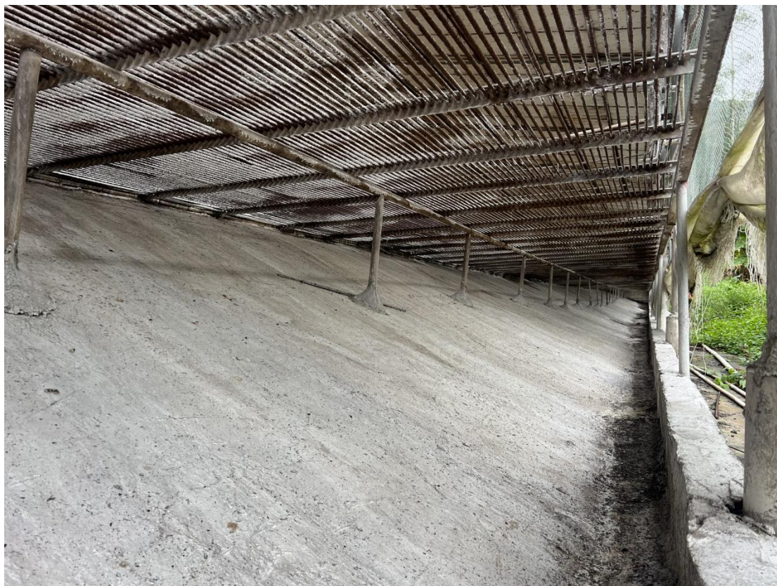
图 3-2.3 猪舍漏缝地板照片
