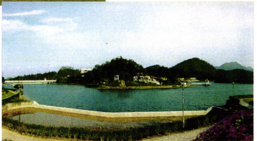
恩平市青南角水库库区
